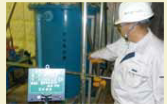
清水揚水機場受水槽点検・清掃業務検査状況
