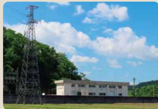
清水揚水機場
