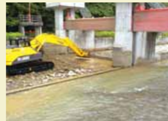
駒場頭首工土砂土砂浚渫状況
