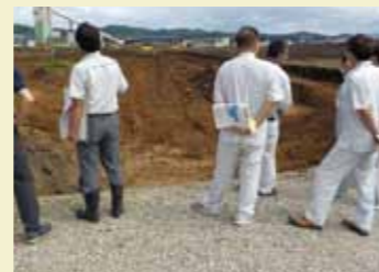
高壇地区面工事状況
