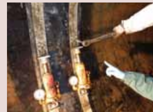
③本管:内面バンド設置状況
