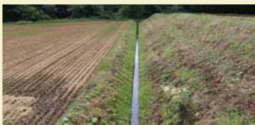
(野中地区維持管理委員会ほ場内の適正に管理された排水路)
