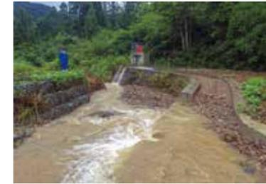
取水口が流入土砂により閉塞
