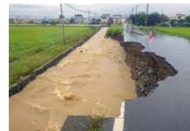
五日町排水路増水による県道崩落
