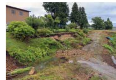
法面崩落による福宮用水路閉塞
