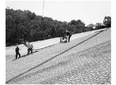
堤沢ため池波除護岸工事
