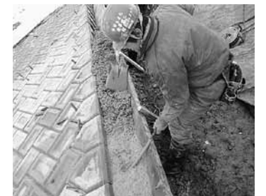
勇堰用水撤去工事
