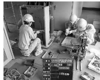
清水揚水機場真空遮断機補修
