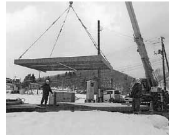
芦沢制水弁蓋板補修
