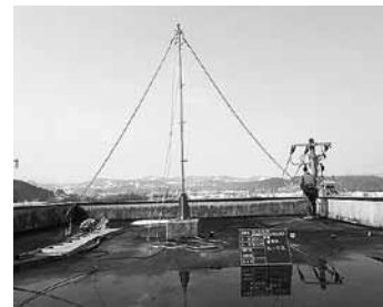
清水揚水機場避雷針更新
