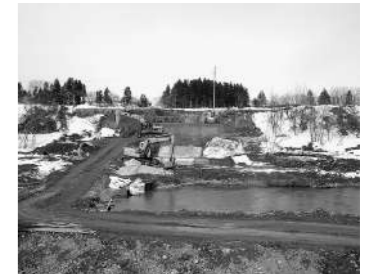
上ミ野堰撤去工事
