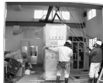
升形揚水機場電気設備更新
