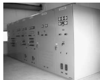
升形揚水機場電気設備更新（完成）
