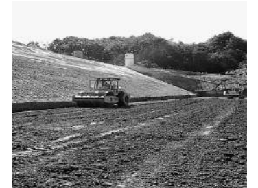
堤沢ため池堤体工事
