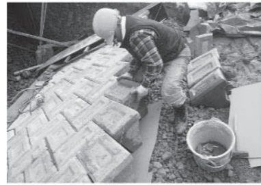
ガニザ用水堰撤去工事
