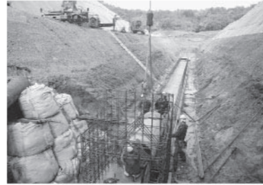
堤沢ため池工事
