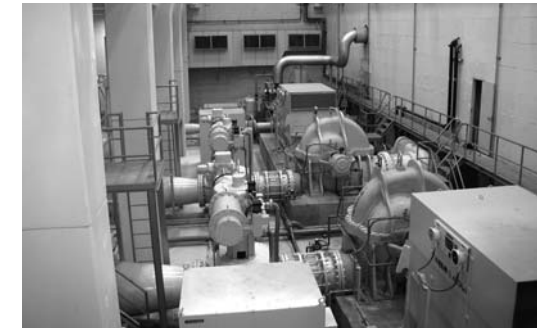
国営清水揚水機場
