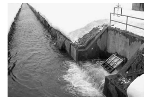
現況河川への注水状況
