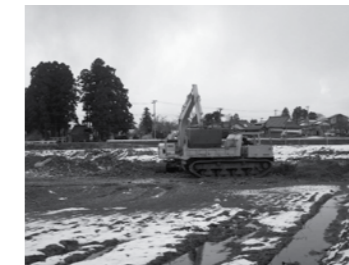
角沢地区流入堆積物除去
