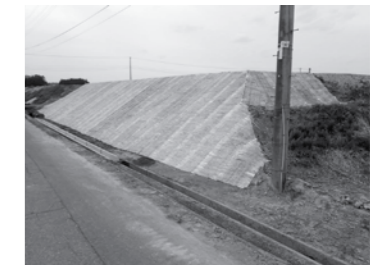
泉ヶ丘地区法面補修
