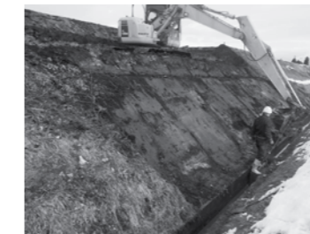
滝の倉地区法面補修
