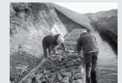
宮野地区法面復旧
