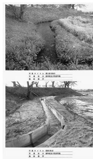
宮田堰改修工事
