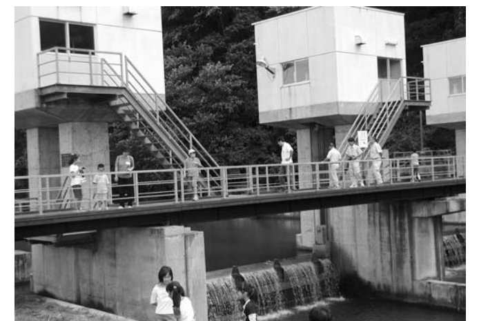
国営駒場頭首工
