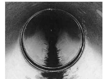
1 幹内面バンド補修
