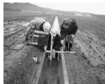
向田用水路布設替
