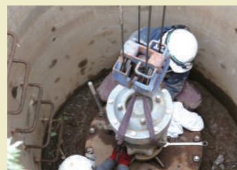
第2号空気弁設置状況
