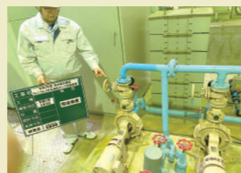
清水揚水機場封水加压ポンプ交換業務検査状況
