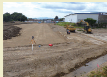
高壇地区面工事状況
