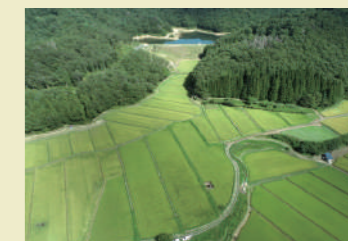
堤沢ため池放水路崩落事故現場状況
