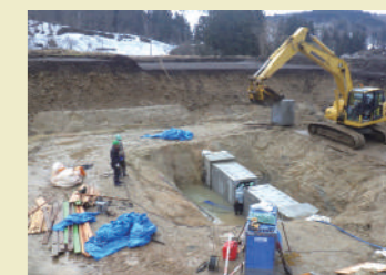
堤沢ため池放水路崩落事故復旧工事
