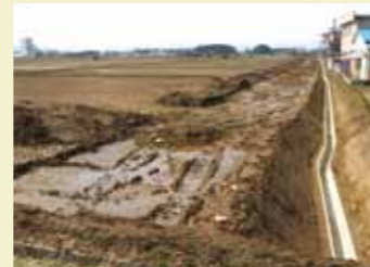
高壇地区排水路工設置
