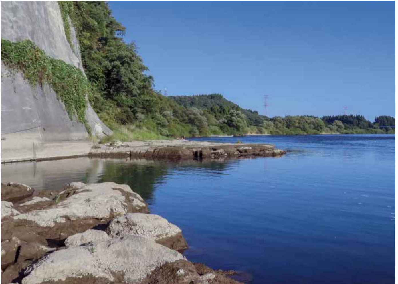
清水揚水機場取水口(最上川)
