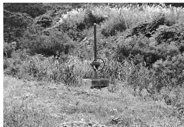
関屋地区現況水利施設
