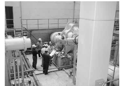
清水主ポンプ振動摩耗対策工事
