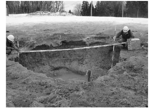
災害復旧工事
