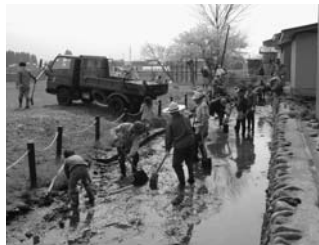
排水路の浚渫
