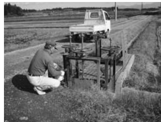
ゲートの塗装
