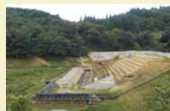
小泉ため池工事風景(1)
