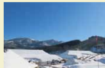
小泉ため池工事風景(2)
